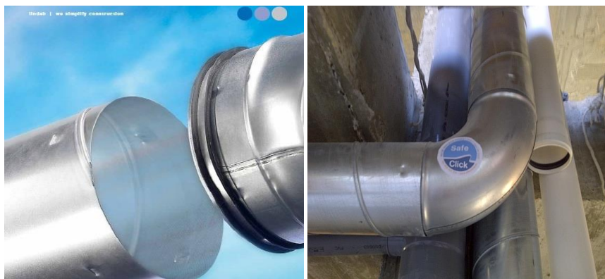
Figura 24. Puesta en obra conductos y accesorios Safe-click. Montaje Red accesorios metálicos con doble junta EPDM flejada con estanquidad tipo D (según EN 12237), con anclaje y fijación sin tornillos.
