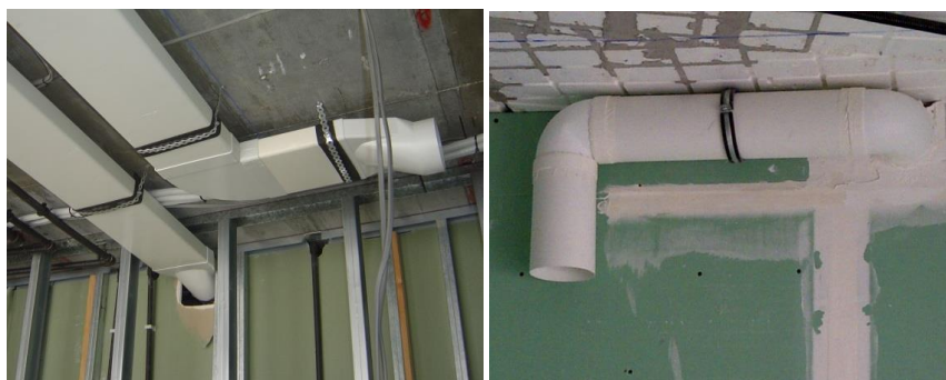
Figura 23. Redes termoplásticas. Montaje en interior viviendas
