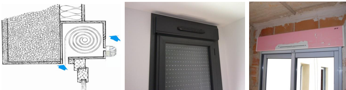
Figura 20. Montaje y puesta en obra entradas de aire en caja de persiana
