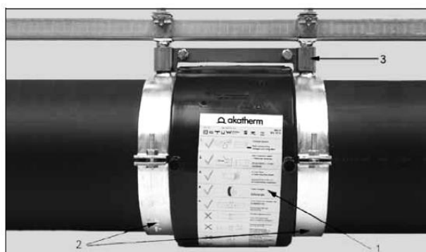
Figura 14: Punto fijo con manguito electrosoldable (1) entre abrazaderas (2) conectadas por eje de unión (3)
