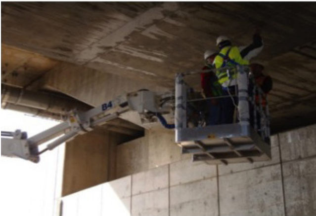
Figura 5 Medidas de corrosión en la parte inferior del tablero del puente de Vidin-Rumania y resultados obtenidos del mapeo.
