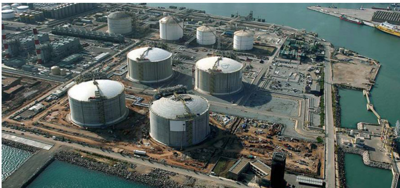
Figura 3. Tanques de Gas Natural Licuado.
