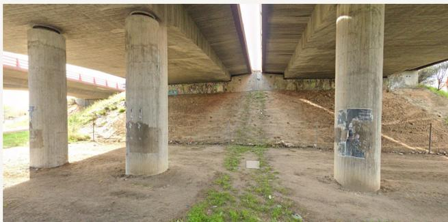
*Estribos de puente afectados por reacciones expansivas de tipo árido-álcali*
